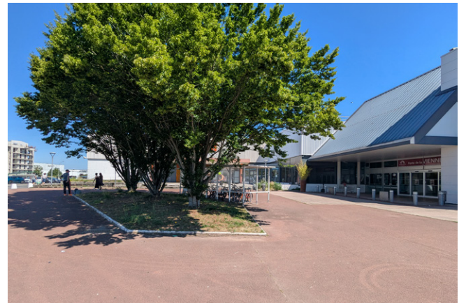
Entrée ouest de la galerie commerciale
