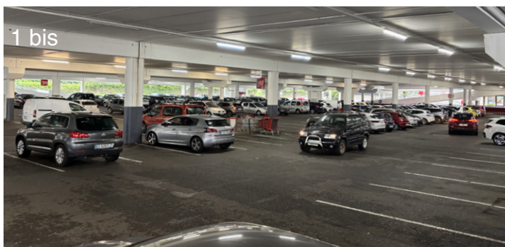
48 Parking en ouvrage - Mercredi 6 mai à 9h11
