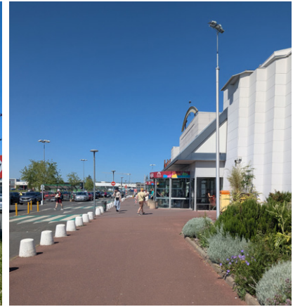
Entrées centrales de la galerie
