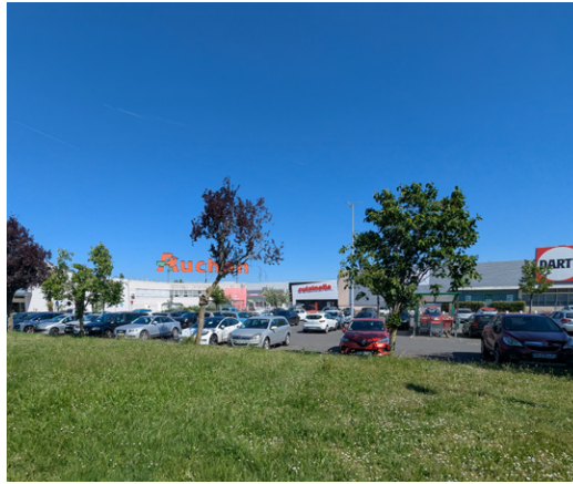
Groupement commercial de l'entrée est de la galerie
