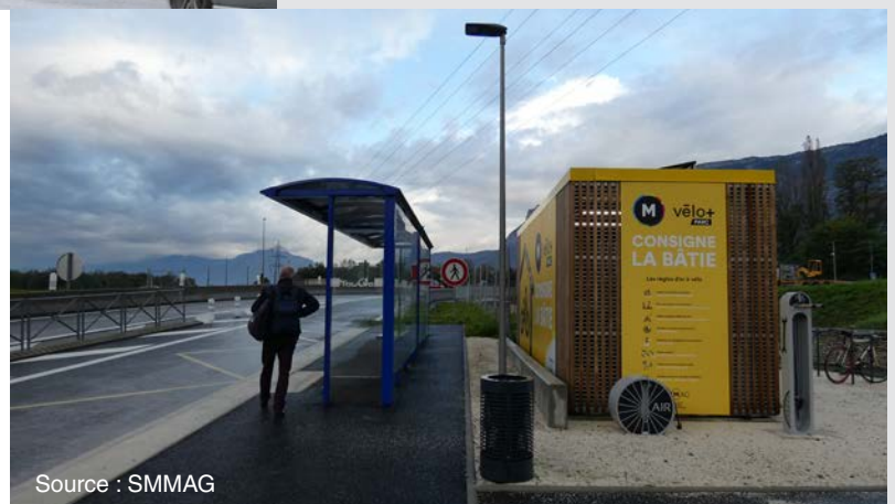
L'arrêt de car « express » et le parc à vélos sécurisé
