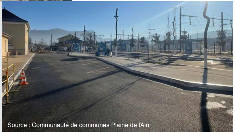
Halte routière en cours d'aménagement en 2024
