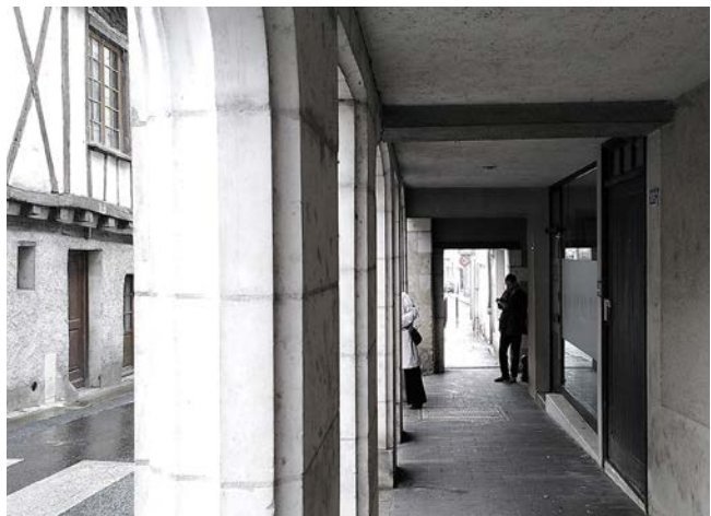
Les arcades dans le tissu bâti ancien, un dispositif pour marcher à l'ombre et au sec
