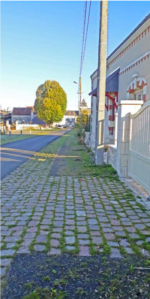
1 - Désimpermeabiliser les seuils des maisons
